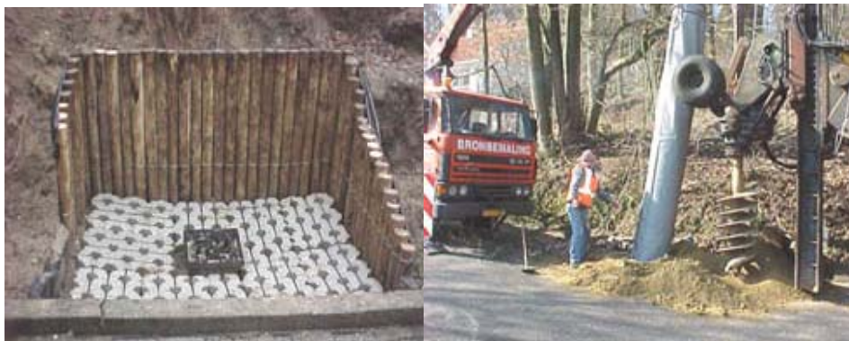
Afbeelding 3.3: Links een civiele lobje en rechts de aanleg van een verticale infiltratievoorziening.
