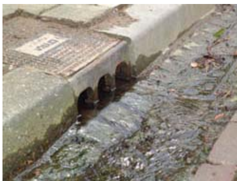
Afbeelding 5.1: Een omgekeerde kolk; water stroomt de kolk uit.
