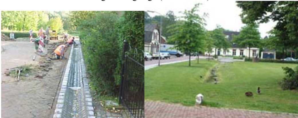
Afbeelding 3.2: Links de aanleg van een stenen beek en rechts een groene beek.
